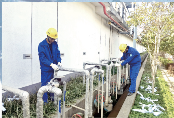
工艺管道包裹保温材料
